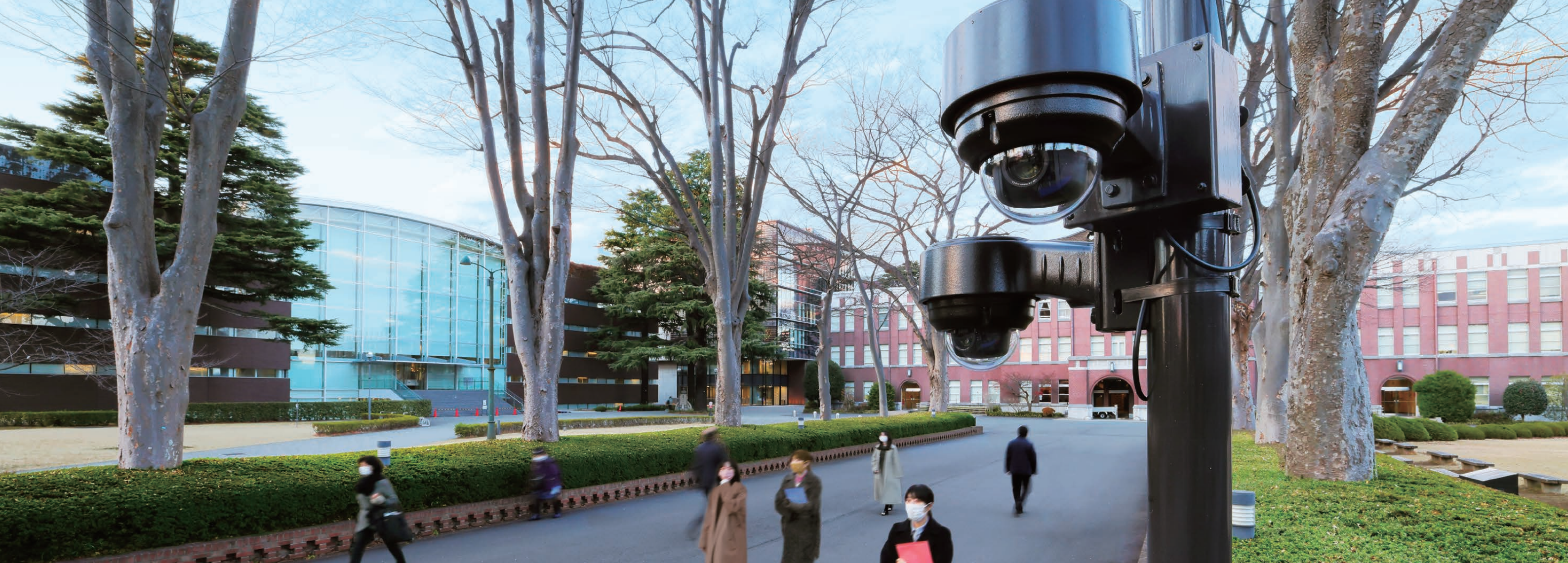
Caméra réseau haute définition installée à proximité du portail principal de l'école
