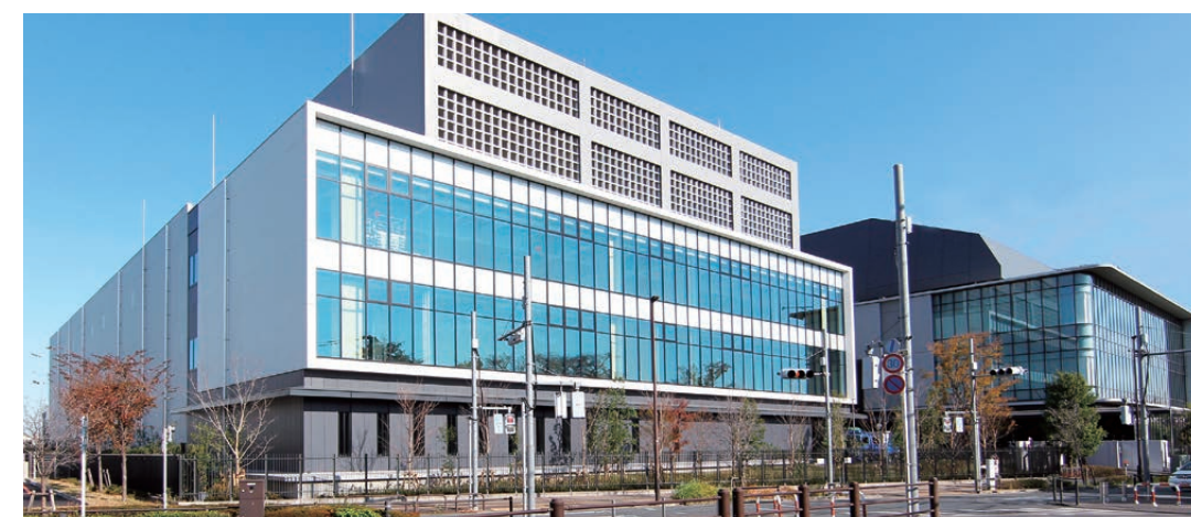
Avec une qualité opérationnelle de dimension internationale, le Nishi-Tokyo Data Center protège les équipements informatiques de ses clients dans un environnement sécurisé
