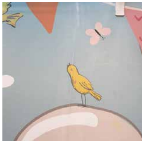
Behang al beschadigd tijdens de installatie
